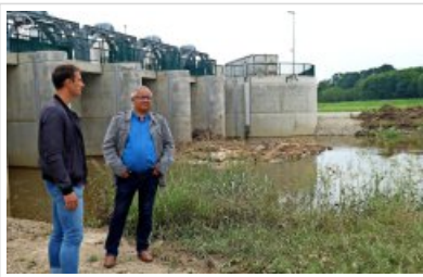
„Halber Thüringer Wald“ angeschwemmt: Flussmeister Martin Etzold (links) und Talsperrenbereichsleiter Axel Bobbe am Verteilerbauwerk in Knauthain. Da waren bereits vier Großcontainer Treibgut entfernt worden. Fotos: Jörg ter Vehn
